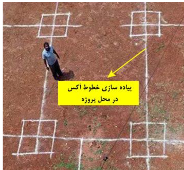
شکل ۸: پیاده سازی خطوط آکس و محل دقیق قرارگیری ستون‌ها در زمین پروژه
